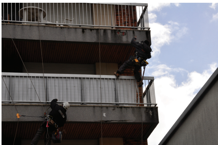
Purge des zones dangereuses par des cordistes (2011)
