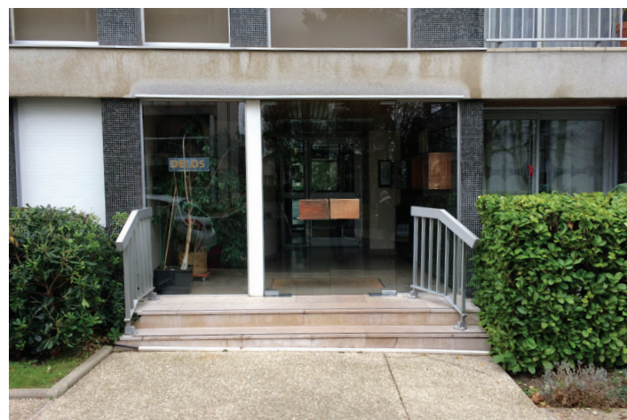
Marches de l'entrée « Delos » avant réhabilitation (2017)
