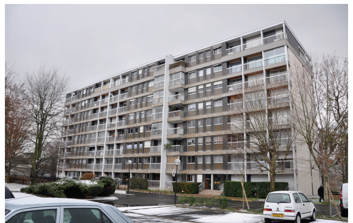
Bâtiment A avant réhabilitation (2011)
