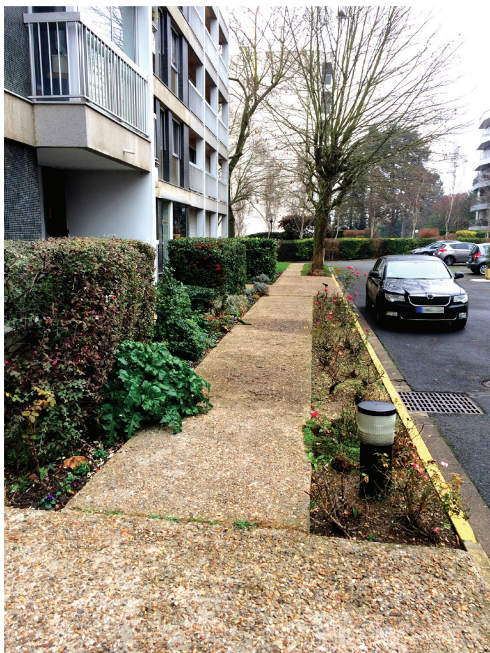
Accès avant intervention (2017)
